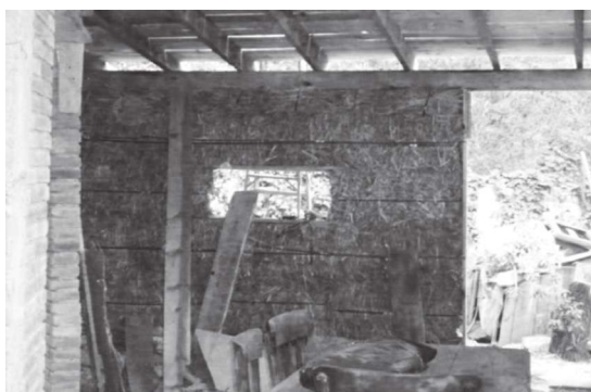
Imagen 10. Construcción con pacas con estructura de soporte
