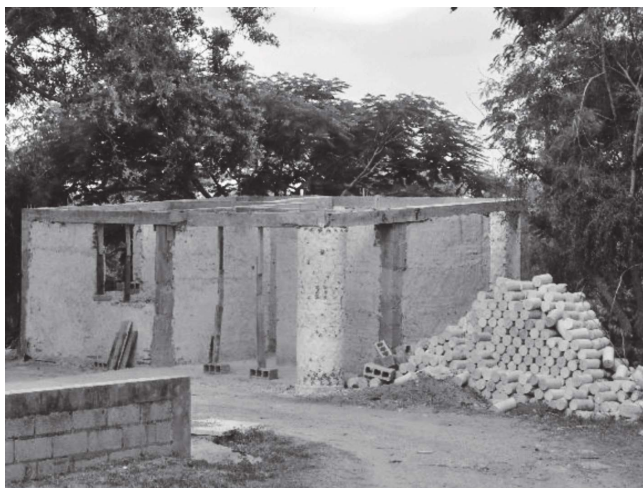
Imagen 14. Construcción con botellas de PET, colado de cadena de cerramiento
