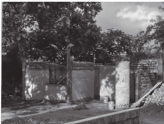
Imagen 13. Construcción con botellas de PET, enrase de muros
