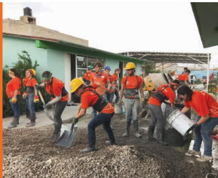
Voluntarios y colaboradores de nuestra comunidad universitaria construyeron aulas para el Centro de Atención Múltiple 72 en el municipio mexiquense.
